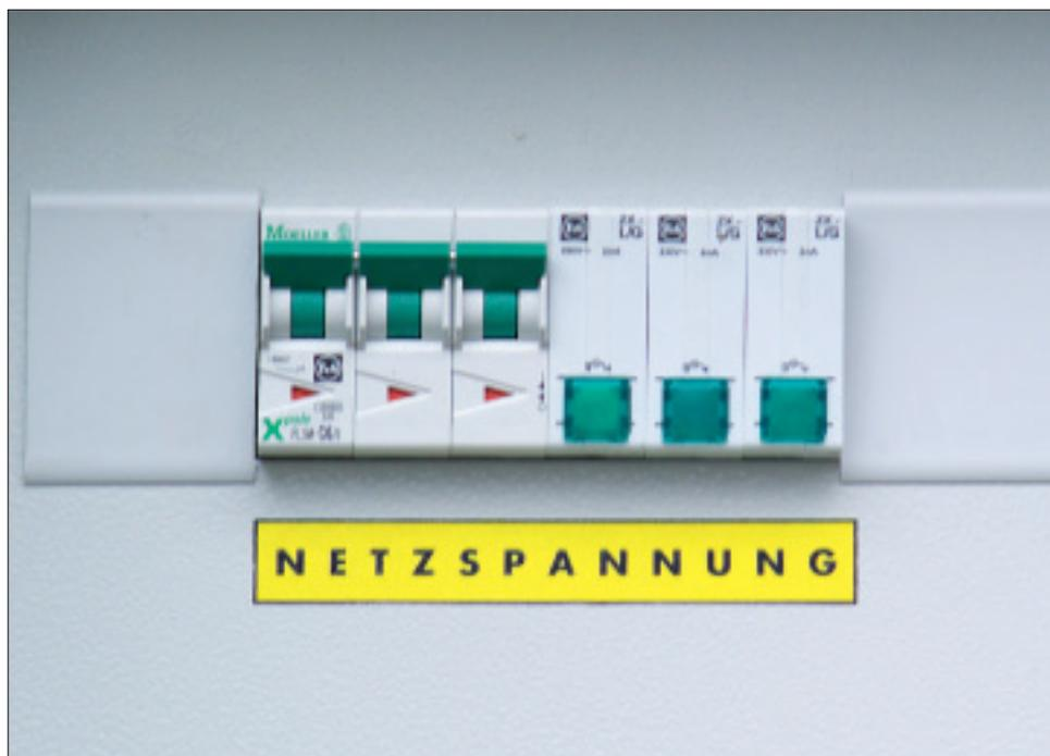
Abbildung 9: Dreipolige Netzspannungswiederkehranzeige
