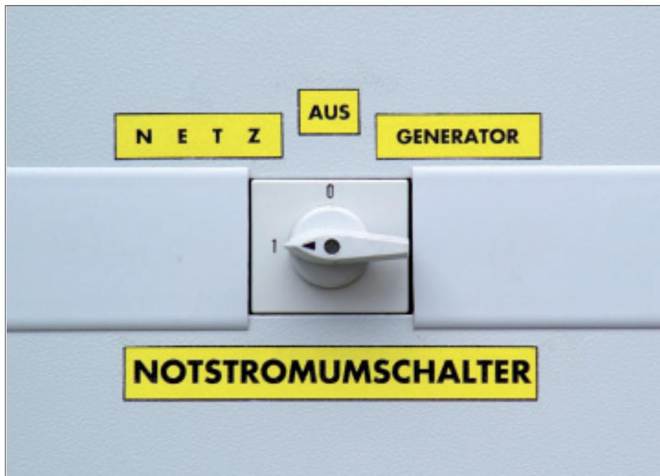
Abbildung 5: Deutlich und dauerhaft beschrifteter Notstromumschalter.
