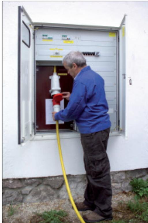
Abbildung 3: Notstromstecker, Nennstromstärke: 63 A
