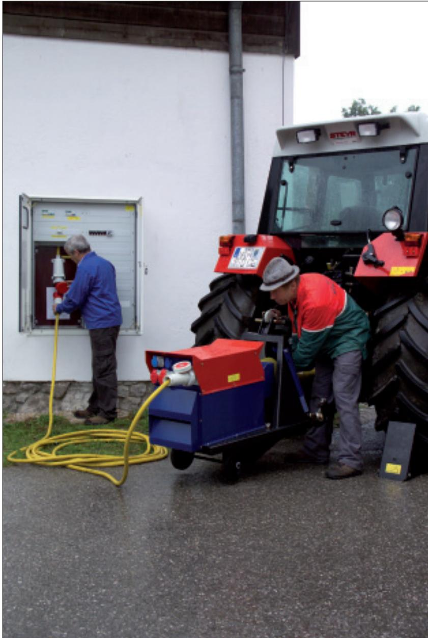
**Notstromversorgung mit einem Zapfwellengenerator**
