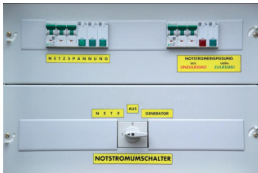
Abbildung 4: Einspeisefeld mit Netz- und „Drehfeldkontrolle“
