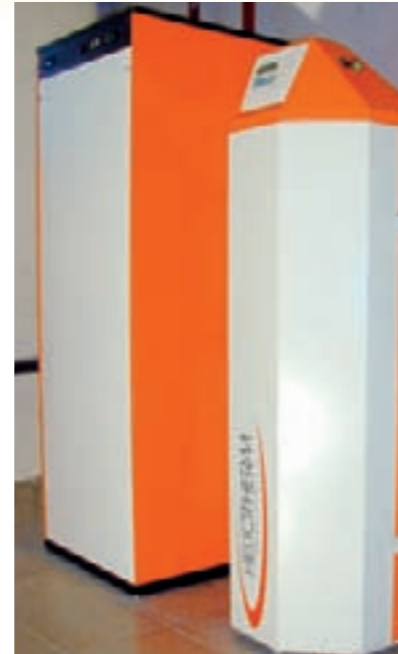
Wärmepumpe und Warmwasserboiler © MECO Erdwärme (Foto: Heliotherm)
