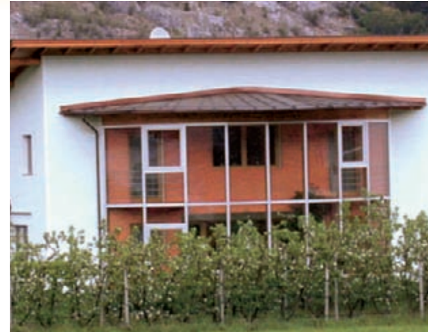
Einfamilien-Niedrigenergiehaus mit großzügigem Wintergarten (Foto: Tiroler Wasserkraft)
