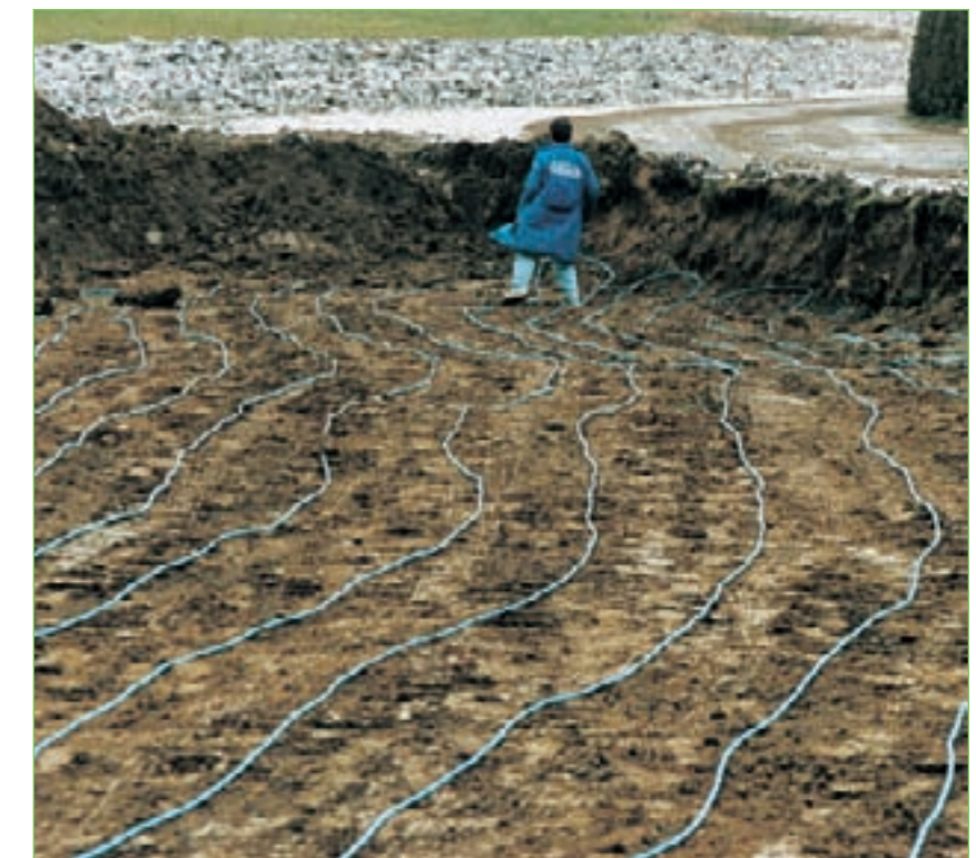
Verlegung eines Flachkollektors
